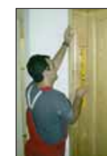
τοποθέτηση κουφώματος σελίδα 46
