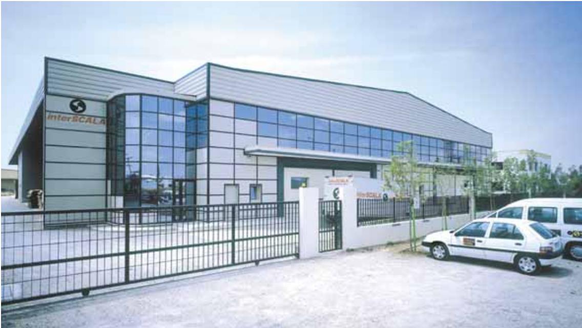
Κτίριο Α: σκάλες - κουφώματα
