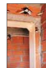
τοποθέτηση ψευτόκασας σελίδα 44
